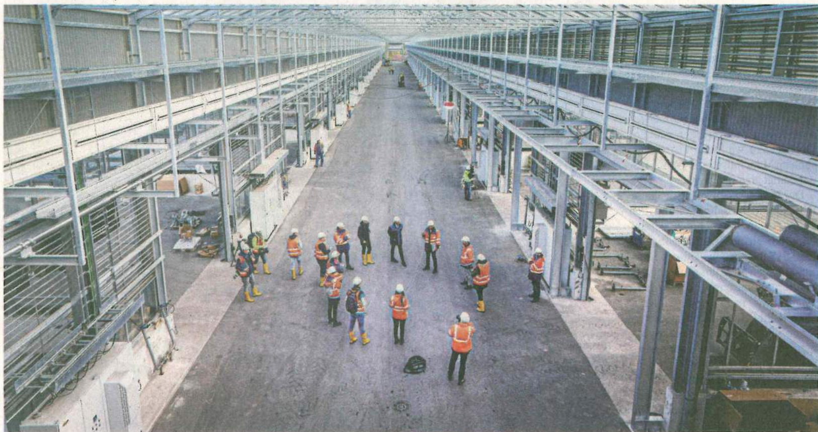
Ein ähnliches Projekt wie das in Thüringen geplante entsteht derzeit in Bottrop. Bis 2021 wird dort an der weltweit größten solarthermischen Klärschlamm-Trocknungs- und Verbrennungsanlage gebaut.
